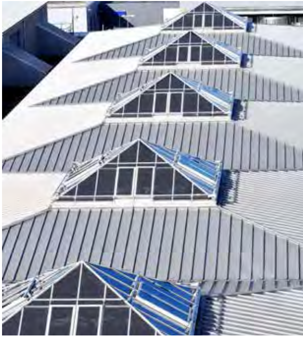
Falsat plåttak och bärande konstruktion i strukturaluminium.
