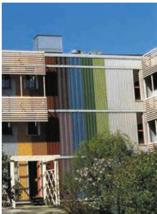
Fig 7.11 Målning av aluminiumplåt ger både ett gott korrosionsskydd och ett dekorativt utseende.
