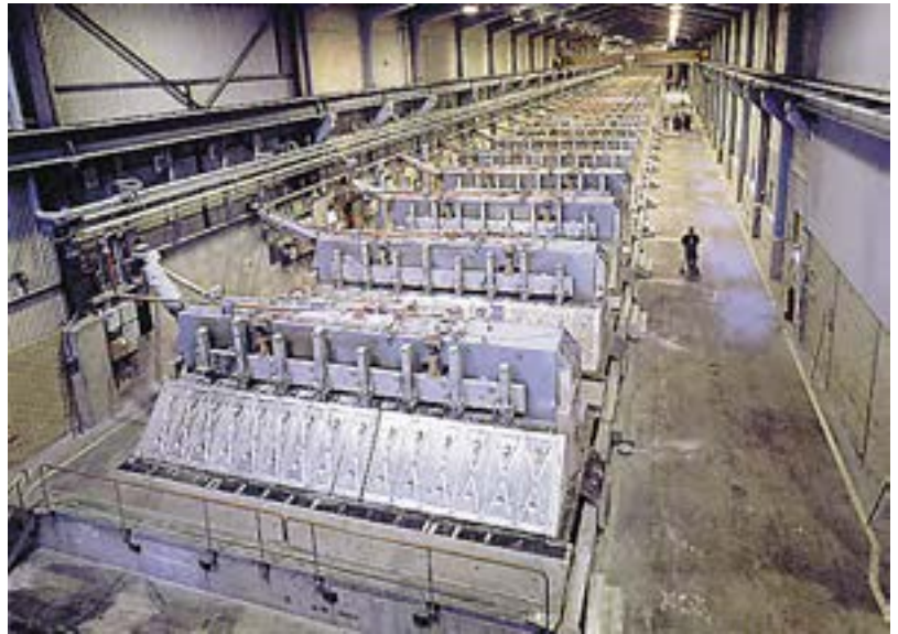
Fig 2.4 Elektrolyshall hos Kubal AB i Sundsvall.
